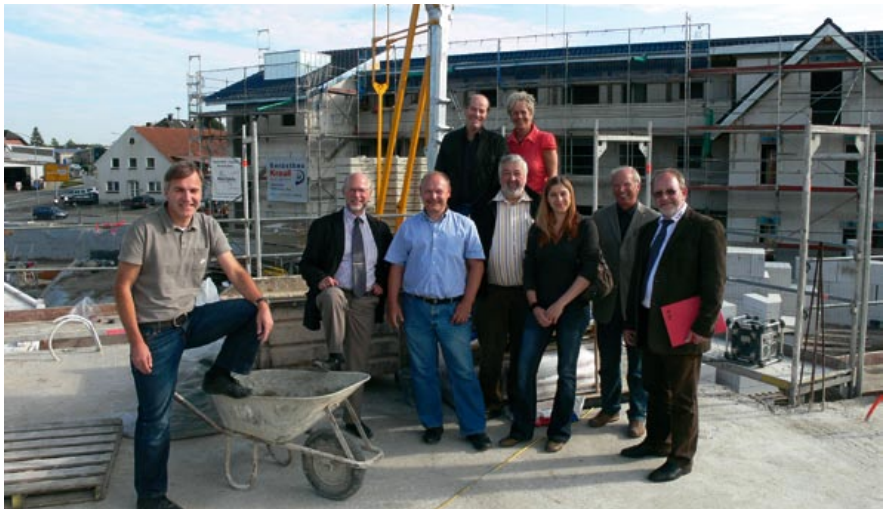
Mitarbeiter des DRK mit Investor, Herr Kelle, freuen sich auf die baldige Fertigstellung des Cara-Vita
